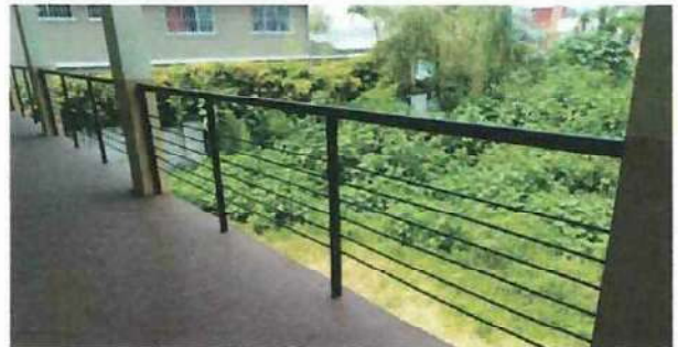
Foto 2: Balcones de pasillos segundo nivel, Diversificado.
